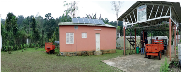
Figura 36 Sistema PV na Cooperativa de café biológico da comunidade de Bem-posta realizada no âmbito do PAPAC / Fonte: DGRNE, 2014 Figure 36 PV system in the biological coffee Cooperative of the Bem-posta community carried out under the PAPAC / Source: DGRNE, 2014
