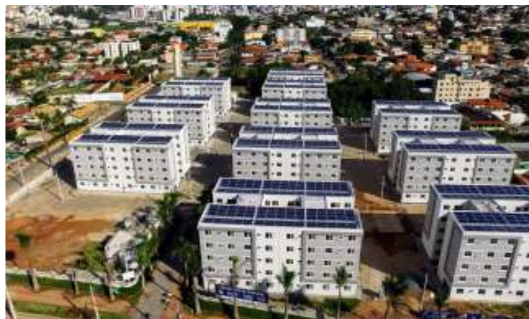
Sistema em condomínio residencial , Belo Horizonte (MG).
