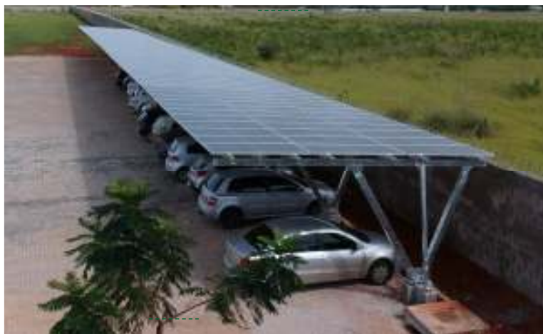
Cobertura de estacionamento , Santa Cruz do Sul (RS).
