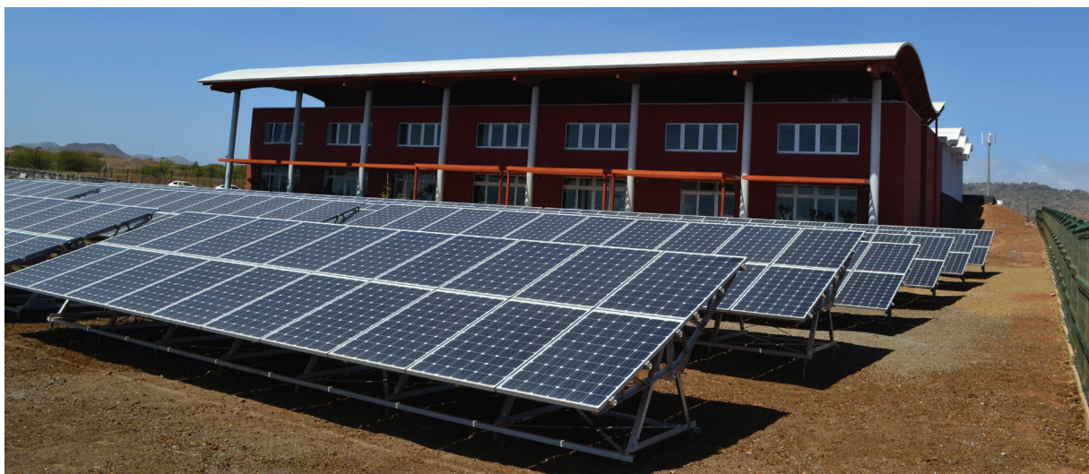
CERMI - Centro de Energias Renováveis e Manutenção Industrial de Cabo Verde - Cidade da Praia, Ilha de Santiago
