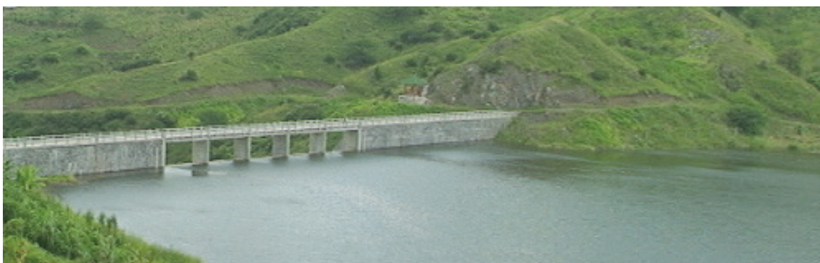
Barragem do Poilão - Concelho de Santa Cruz - Santiago
