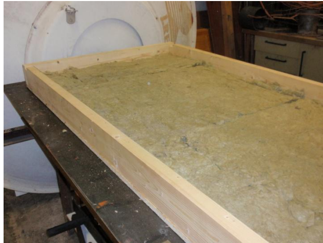
Figura 3.18 Imagem da caixa com isolamento já colocado
