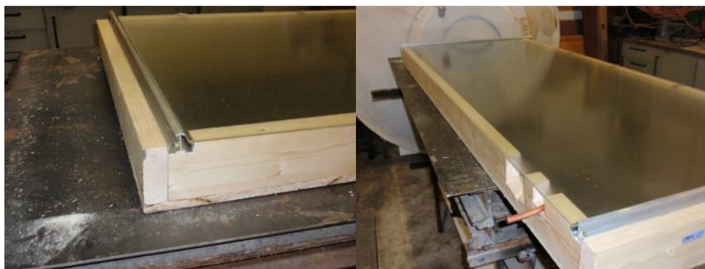
Figura 3.28 Vistas do colector já montado
