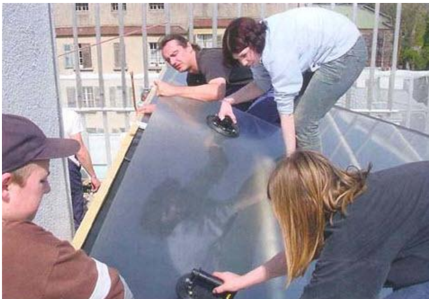
Figura 1.14 Colocação por parte dos jovens do vidro sobre os colectores, Fonte: http://www.sebasol.ch/presentation.asp?rubrique=5
