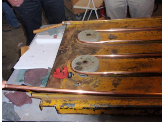
Figura 3.5 Alavanca de dobra dos tubos
