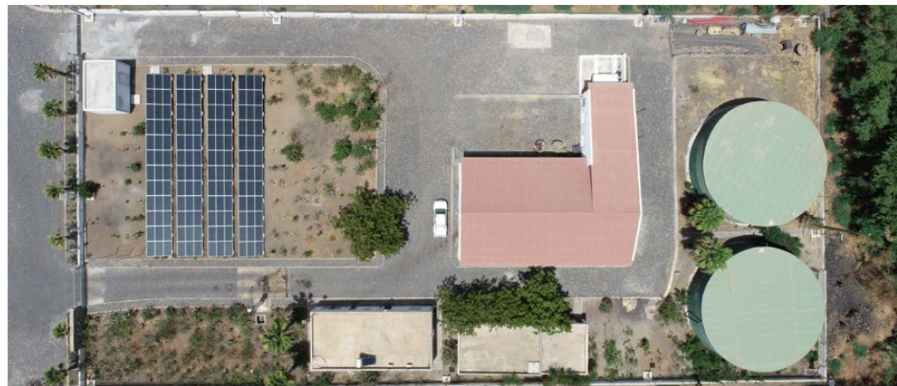
Figura 3: Fotografia aérea da Central de Desalinização de Porto Novo.
