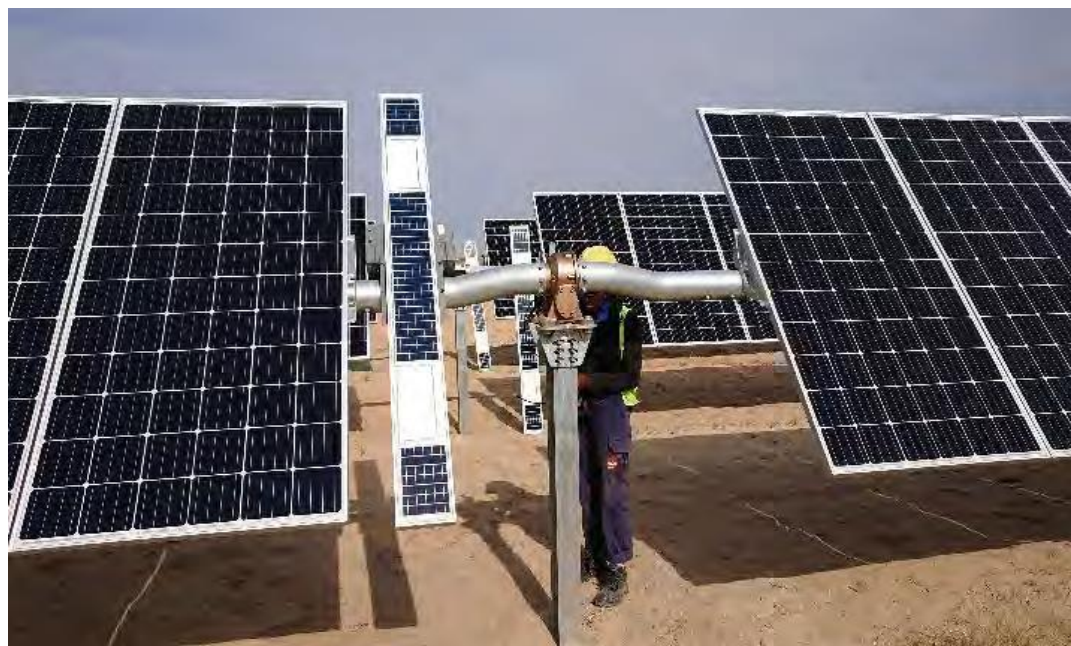
Instalação dos painéis fotovoltaicos na central de Baía Farta
