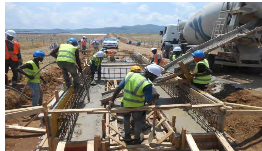
Trabalhos Construção Civil na Central do Biópio Instalar 1 milhão de painéis solares
