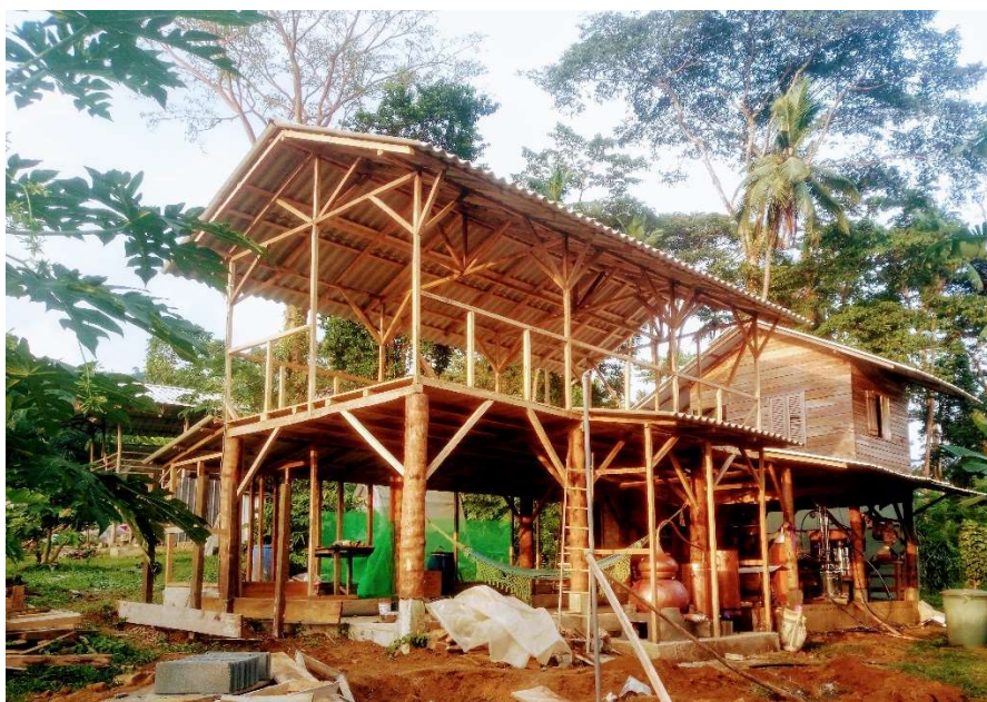
Destilaria e Centro de Atendimento em construção (foto junho 2022)
