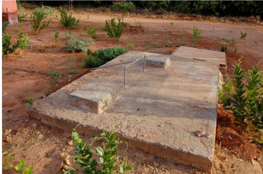
Fig. 8 – Digestor subterrâneo
