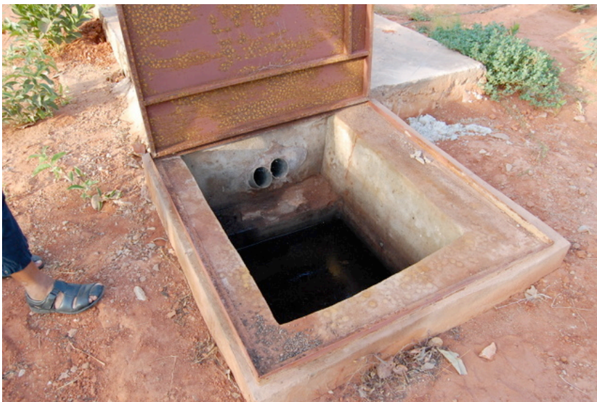
Fig. 9 – Tanque colector de efluente
