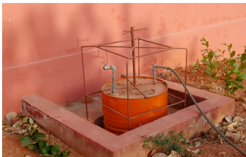
Fig. 7 – Reservatório colector de biogás
