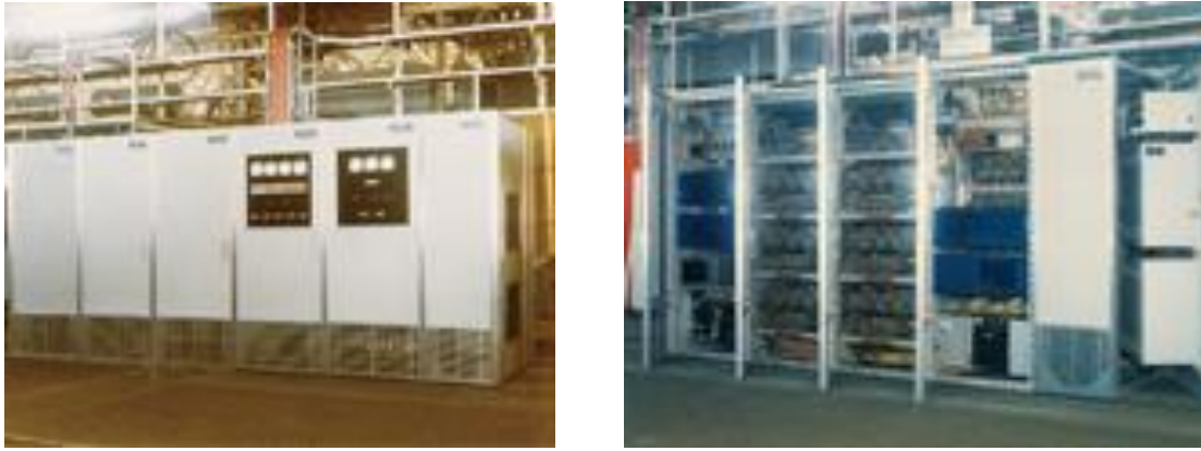
Figura 2.1 – Fotos da UPS instalada no aeroporto em Tóquio [7]
